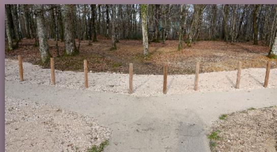
parking en bois avec chicane pour piétons, adaptée au passage P.M.R et la pose d'une barrière d'accès au site.
